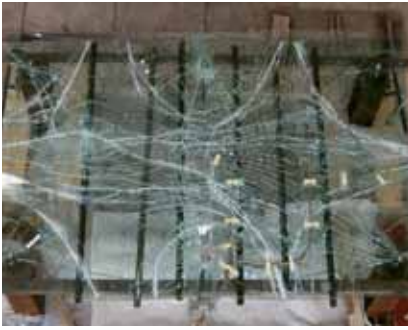
Fig. 6.19 - Vista della lastra collassata
